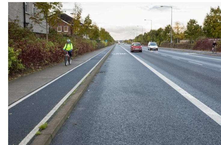
Raonta Rothar ar Bhóthar Dáileacháin Ongar i mBaile Bhlainséir
