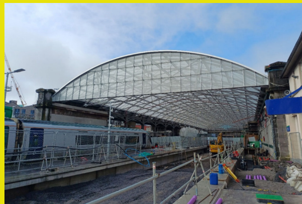
Galway Ceannt Station New Roof
