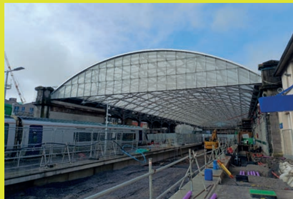
Galway Ceannt Station New Roof
